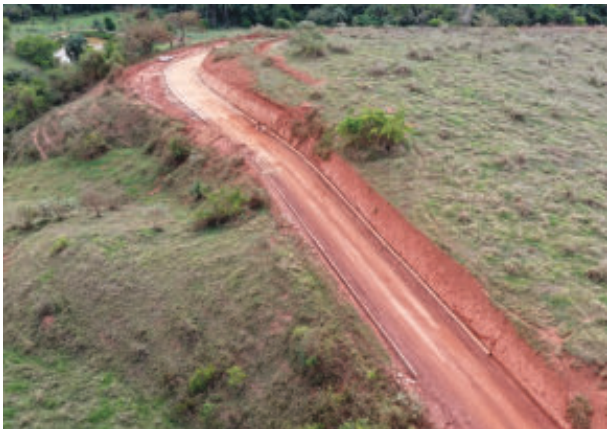
Além do calçamento, estão sendo feitos serviços de drenagem
