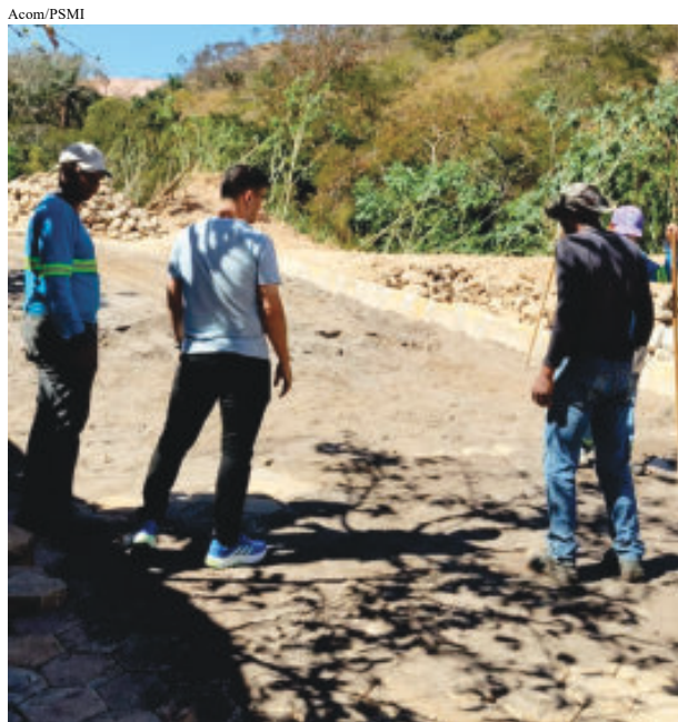
André Torres e servidores da Secretaria de Obras durante execução de serviço de calçamento
