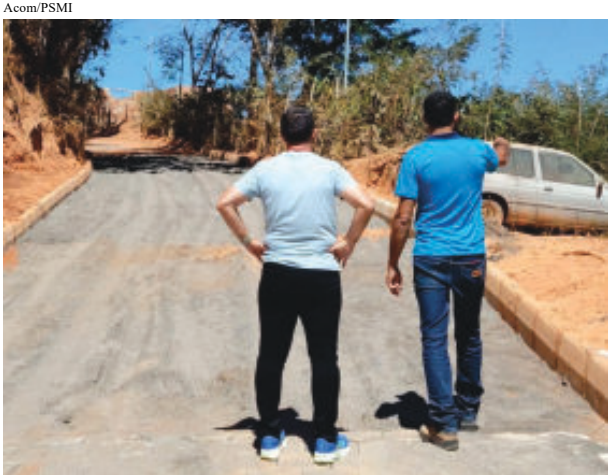
André Torres e secretário de Obras, Paulo Henrique, visitado obras de calçamento
