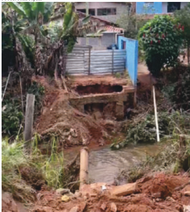
O antes e o depois da obra. Ponte de madeira não resistia às fortes chuvas, se agravando com a enchente de 2021
