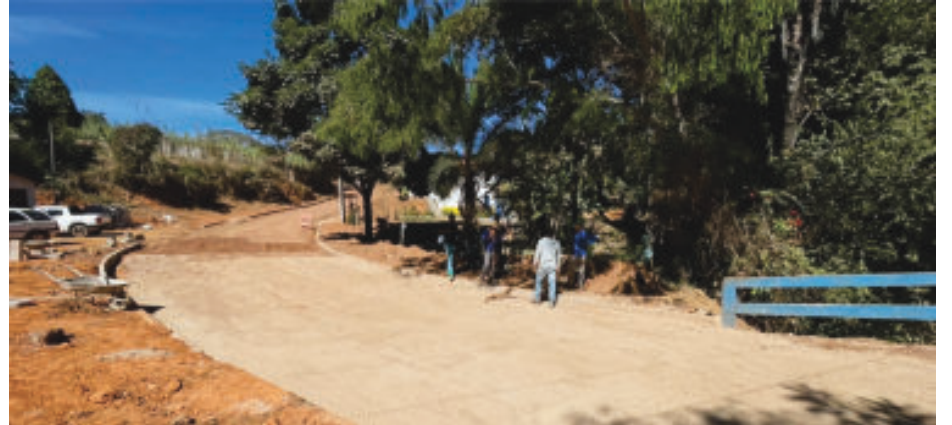
Esta é a segunda fase da obra na comunidade de Porto
