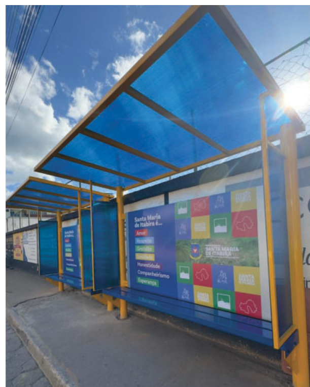
Os abrigos estão instalados ao longo do corredor central da cidade
