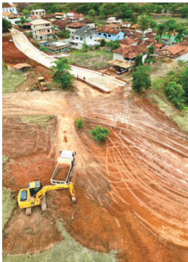
A obra prevê 2,5 mil m 2 de edificação
