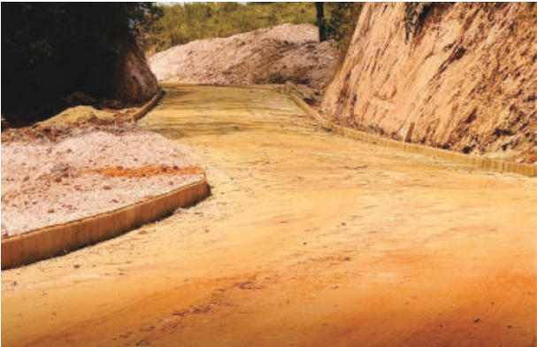
A obra foi realizada em um ponto que antes dificultava o acesso dos moradores
