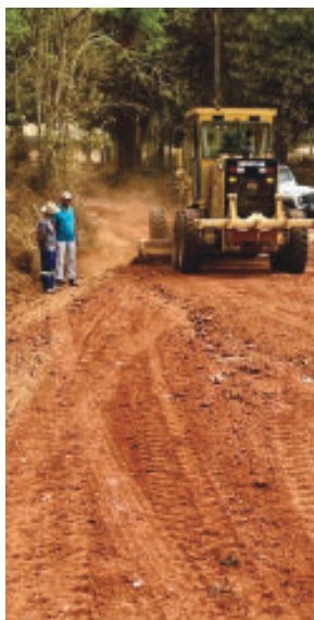
Colocação de cascalho prevendo a chegada das chuvas
