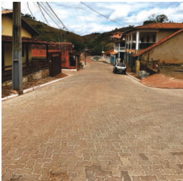
Trecho da rua Joaquim Pereira Chaves também já conta com a obra de calçamento finalizada
