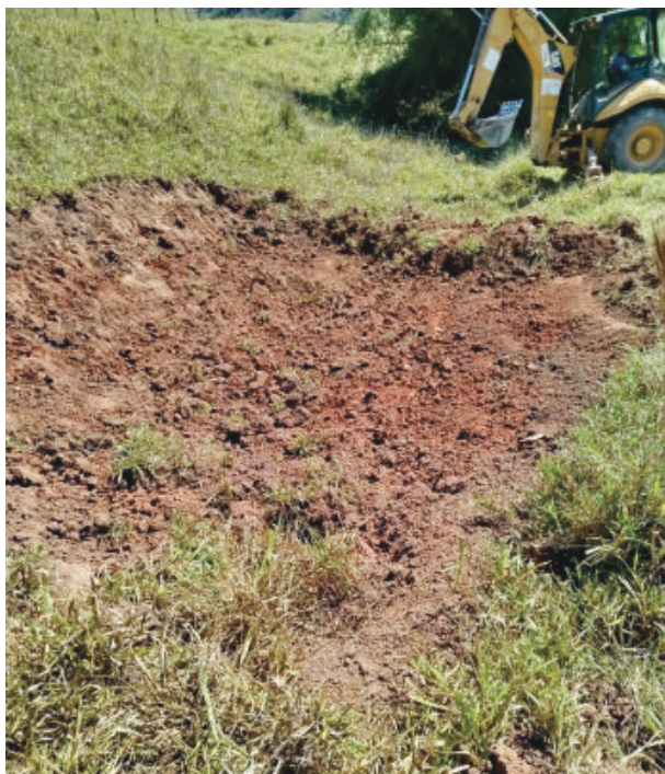
Entre os serviços estão a abertura de lagoas
