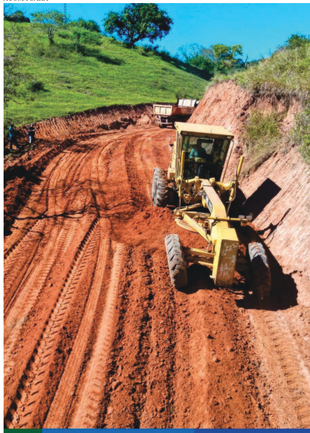
O projeto de pavimentação e calçamento das estradas, contempla no momento a região do Batalhão, onde a obra está em plena atividade
