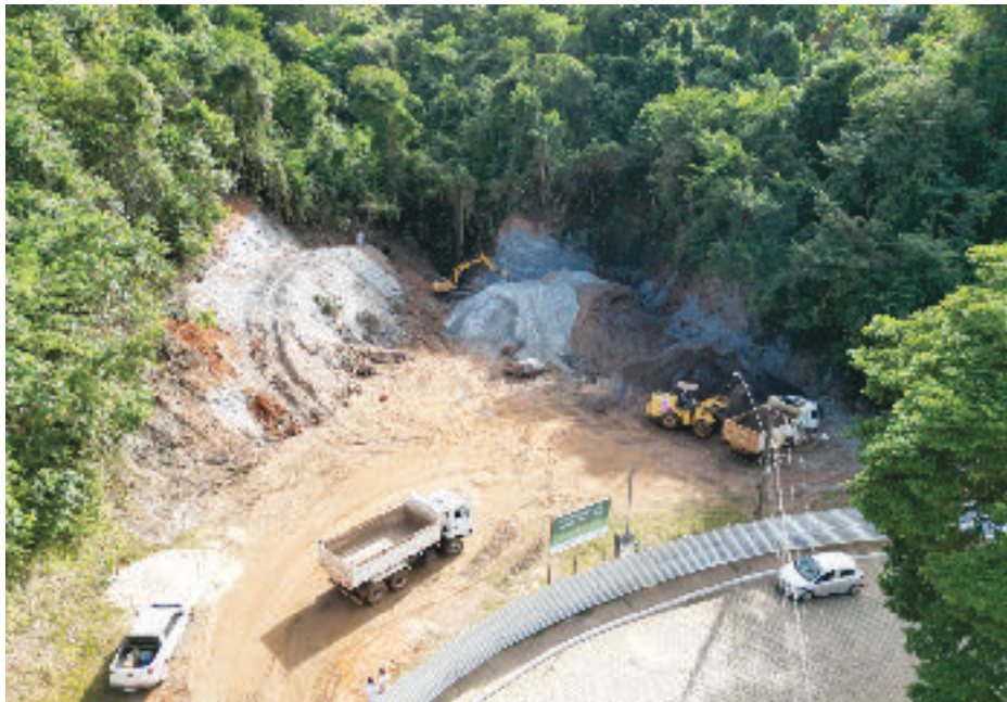
Investimento foi de R$ 1,8 milhão e prazo de execução de um ano e meio
