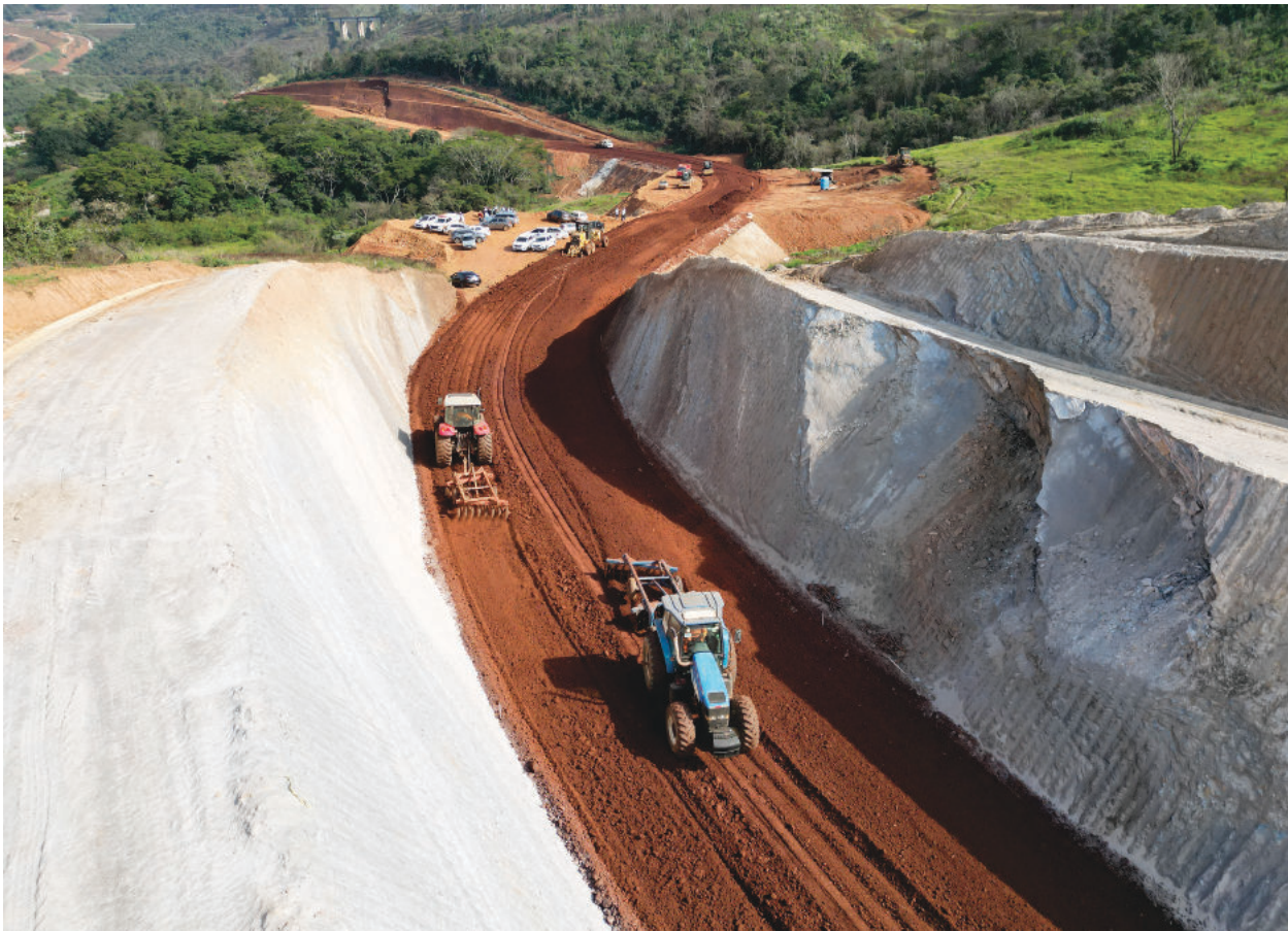
O traçado, de 2km, está em fase de terraplanagem e tem previsão de ser concluído até novembro
