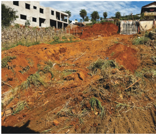
O local passou por limpeza recentemente para receber as marcações para a obra do anexo
