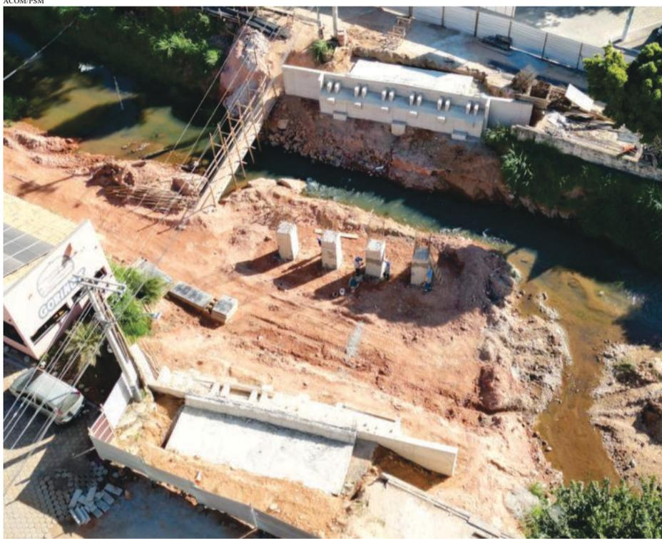
Obra está perto de receber a estrutura pré-fabricada da ponte
