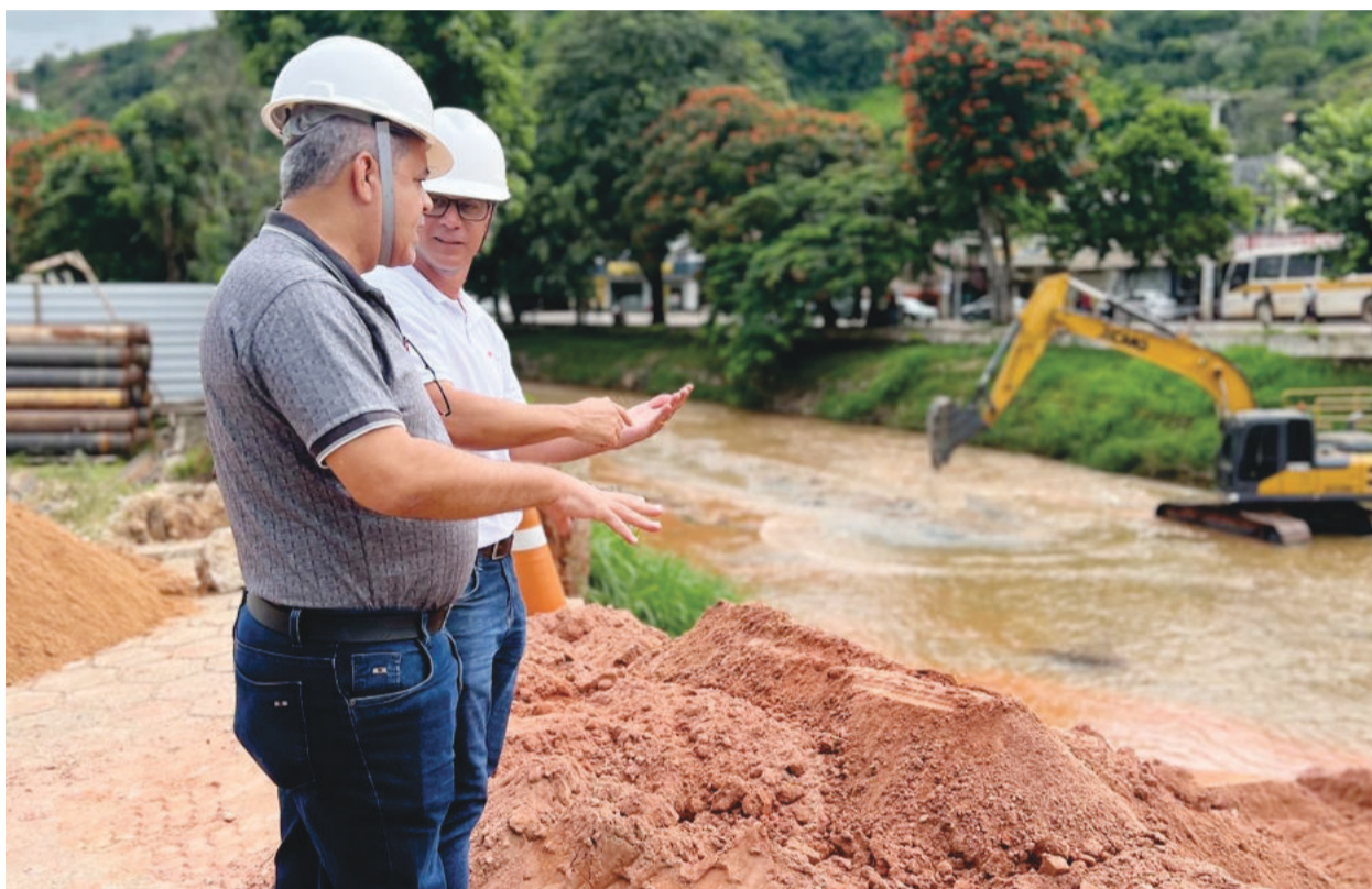
Prefeito Reinaldo Santos e o engenheiro responsável pela obra na manhã desta segunda-feira (4)
