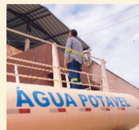
Saae usa caminhão para encher caixas
