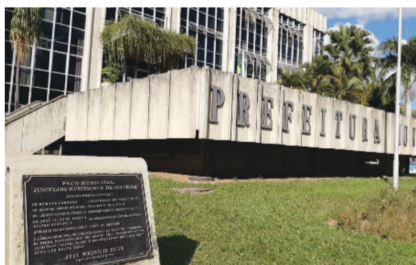
Prédio da Prefeitura de Itabira
