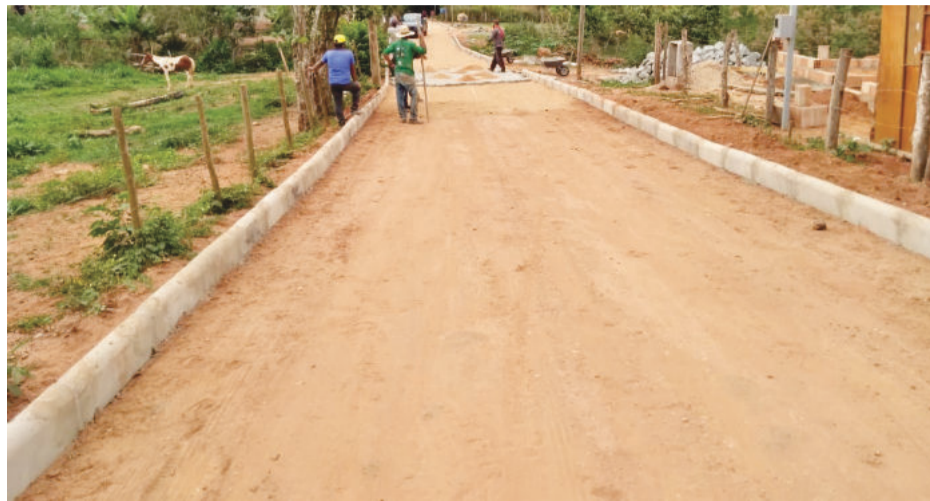
O calçamento em Córrego das Rosas está em fase final
