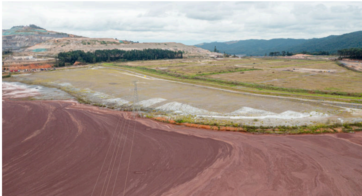
Dique 1A, em Itabira, é a nona estrutura a entrar em obras das 18 que estão no processo
