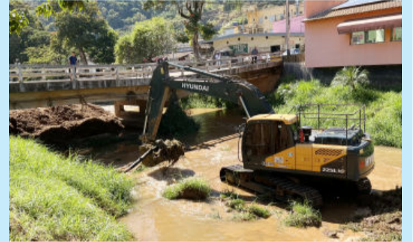
Nova estrutura custará R$ 2,2 milhões
