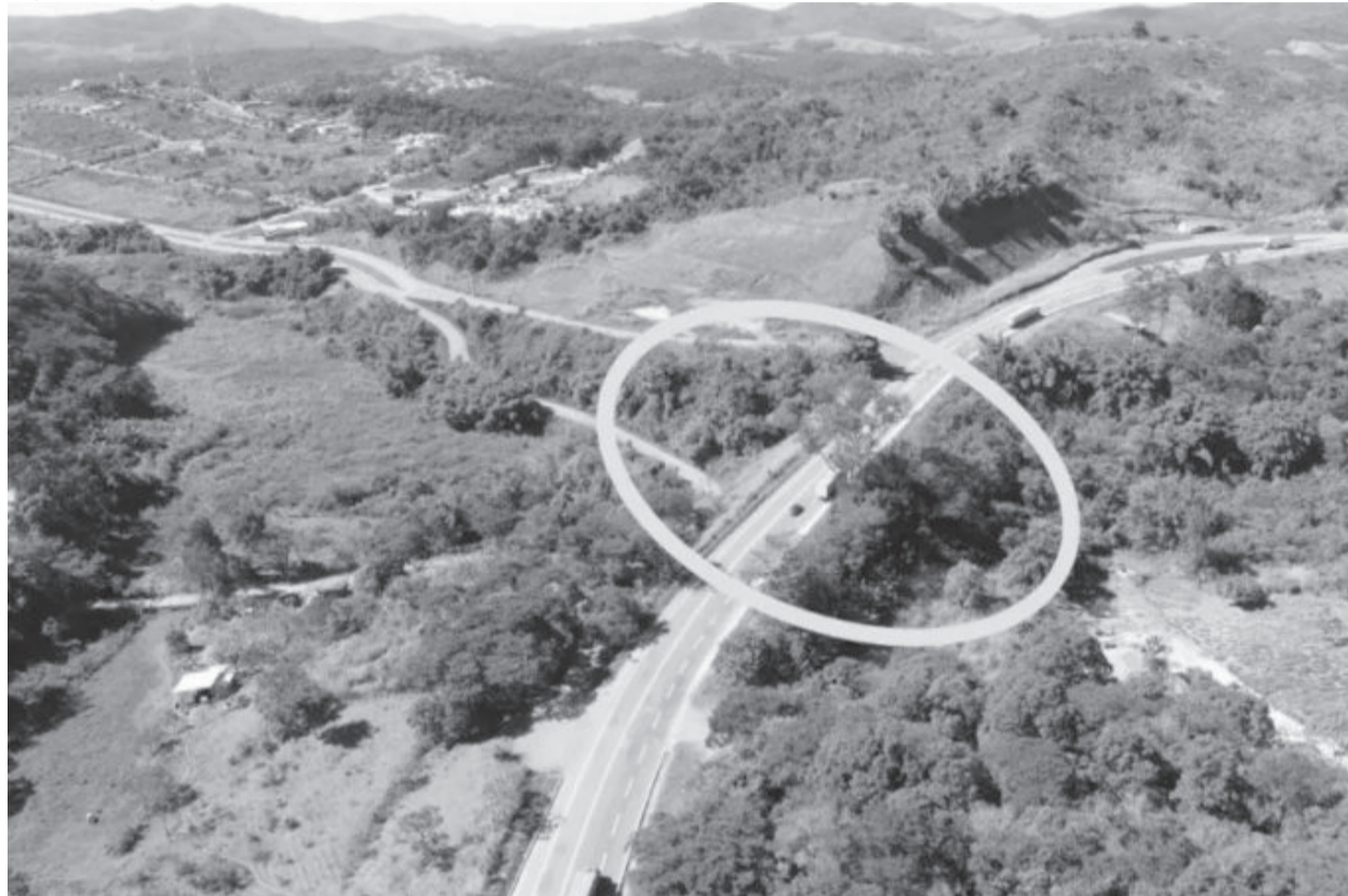
Obra do trevo na BR-381: construtora reduziu ritmo dos serviços e não revela os motivos. Prefeitura também se recusa a falar sobre a obra, que pode custar R$ 26 milhões a mais
