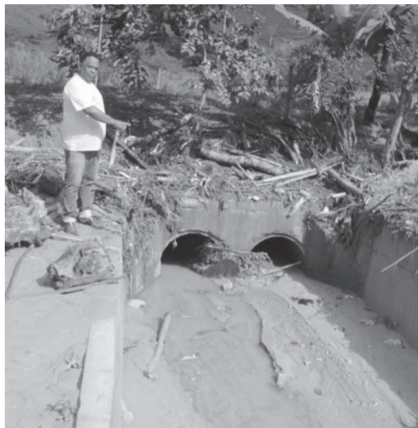
Mesma situação ocorre devido a manilhas inadequadas, mostradas por Vicente Umberto
