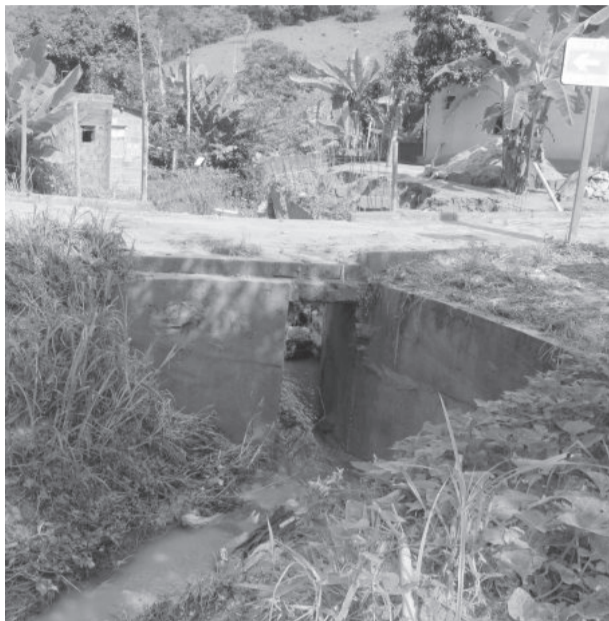
Vazão da ponte não suporta volume da água e transforma local em uma lagoa
