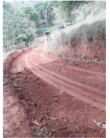
Estrada sendo recuperada
