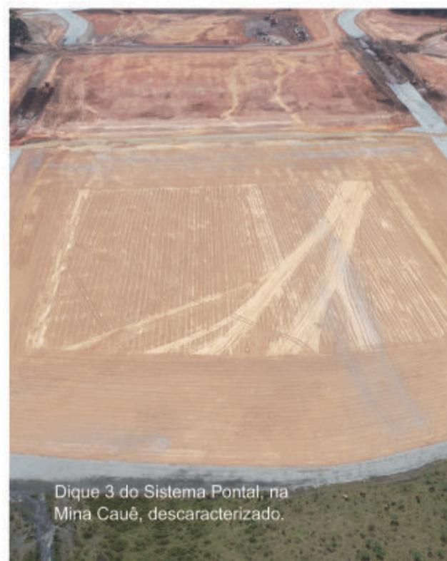
Dique 3 do Sistema Pontal, na Mina Cauê, descaracterizado.
