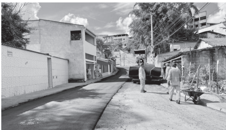
Obras tiveram início em novembro de 2021. Chuvas e minas de água atrasaram a conclusão dos serviços
