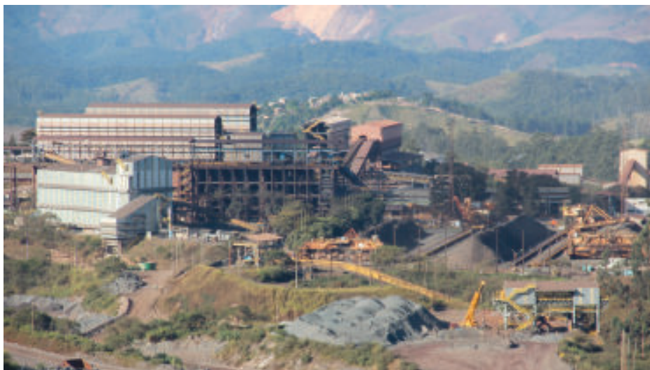
Usina do complexo Cauê, da Vale, em Itabira em junho de 2021
