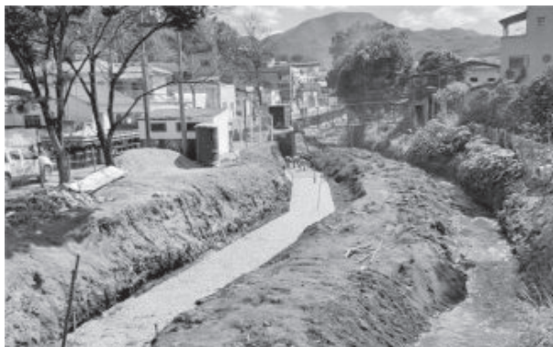
A obra conta com intervenção em 47 metros de comprimento do rio
