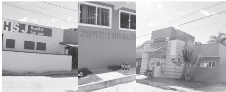
Hospital São José, Centro de Saúde e Unidade Básica de Saúde de Passabém
