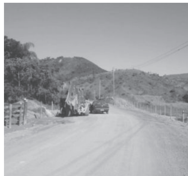
Obra foi interrompida pelo MP, mas deve receber novo projeto de execução
