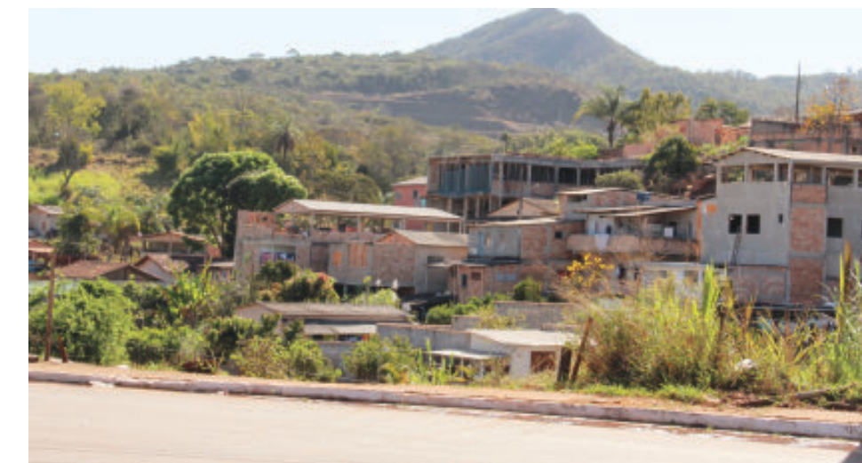
Reserva vista da rodovia de acesso a Barão de Cocais, trecho do bairro Garcia
