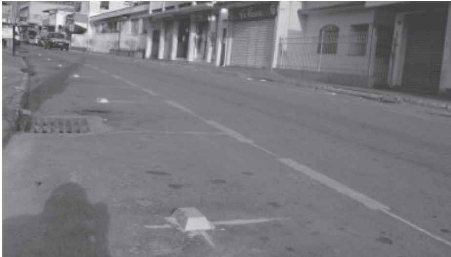
O sensor, inserido em tachões, permitirá a gestão das chamadas vagas inteligentes
